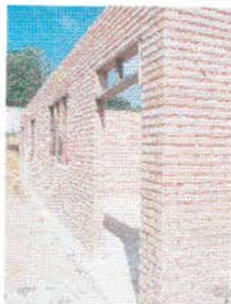
Vista da fachada externa de residência em construção.
