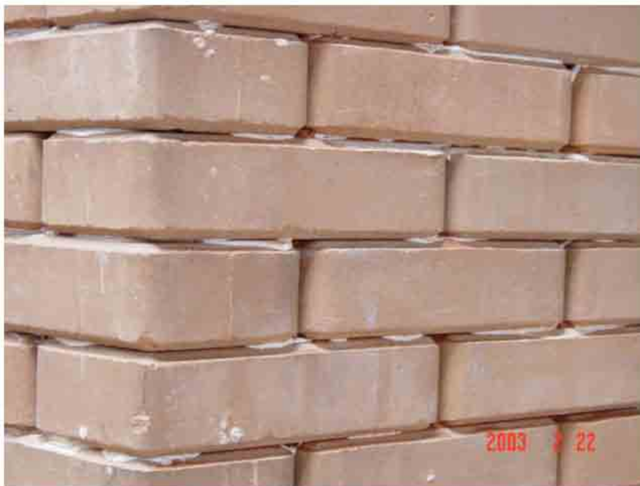
Foto 3 – cunhal de alvenaria de tijolo de solo-cimento à vista, assentados com cola de PVA.
