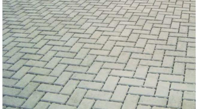
Figura 6 - Pavimento intertravado permeável com juntas alargadas
