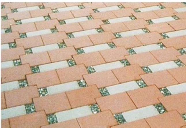
Figura 8 – Exemplos de peças com aberturas para passagem de água. Os formatos apresentados são apenas exemplos e podem estar protegidos por direito de patente.
