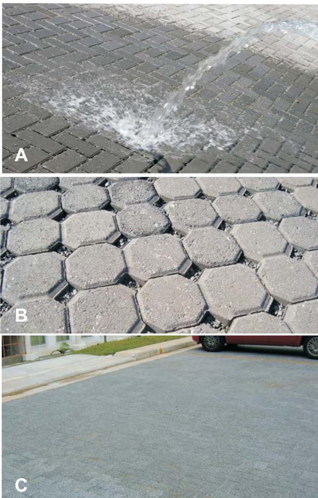
Figura 5 – Tipos de revestimento para pavimento intertravado permeável
